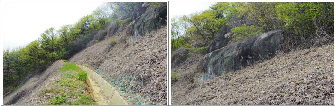
STA.0+80 자연사면 자연암반
