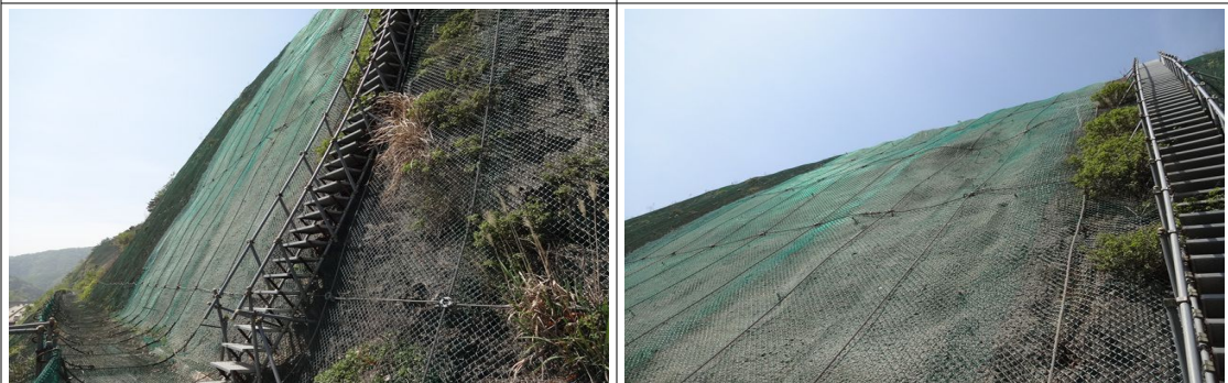
71.68K 2단 슛크리트 전경
