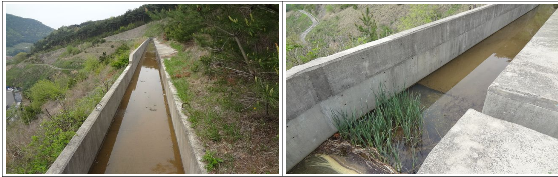
(2/3) STA.0+20 2소단배수로 채수
