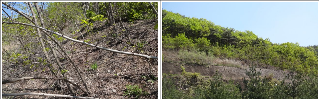
STA.0+70 3단 표층유실
